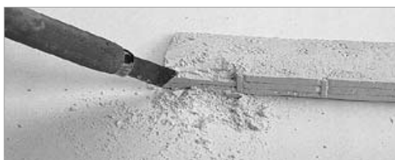
Abschaben einer Schwelle am Schüttbahnsteig 2158.
