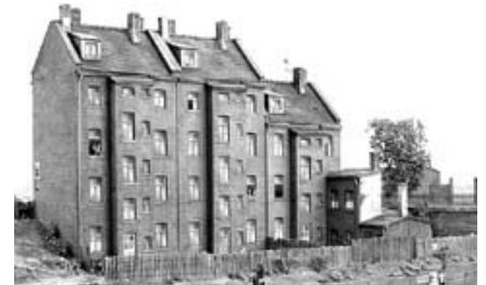
Zum Hausbau mit Gips ist die spezielle Grundlagenanleitung „Stadtlandschaft“ erhältlich
